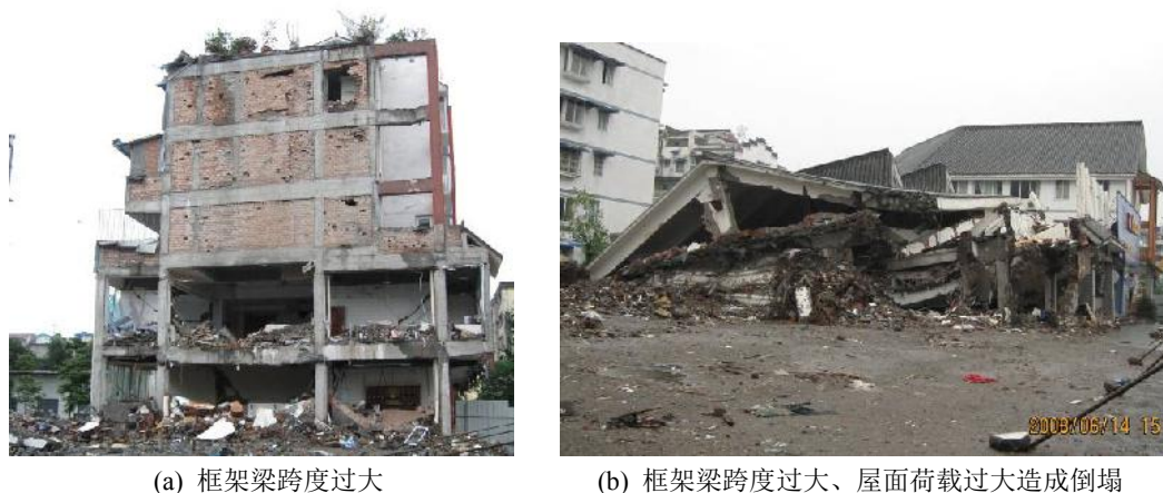
图 6 框架梁跨度过大、荷载过大使梁截面尺寸增大
