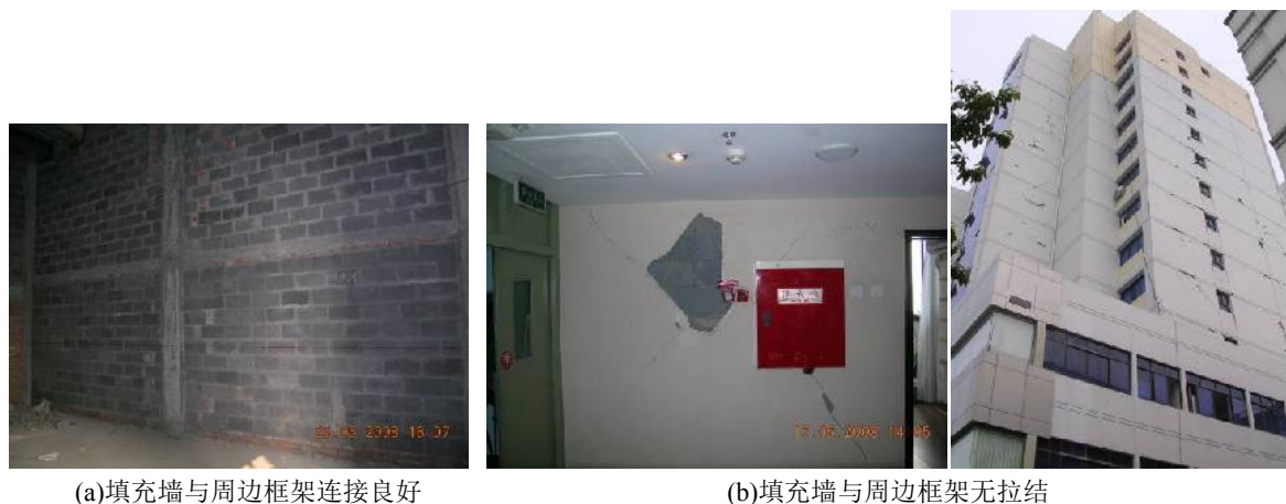
图2 填充墙与周边框架连接状况与震害情况
