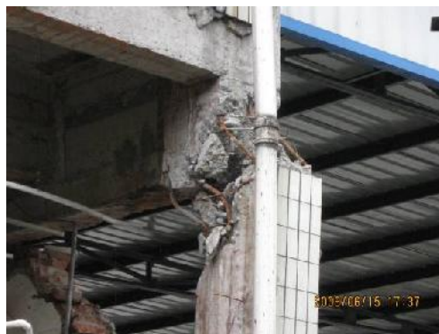
(e) 柱端出现塑性铰后产生剪切破坏
