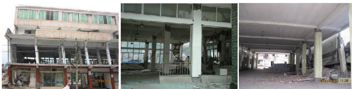
(j)柱端产生塑性铰形成层屈服机制
