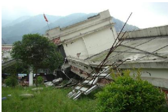
图 8 映秀镇漩口中学教学楼倒塌
