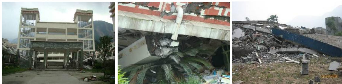
图7 框架柱太细
