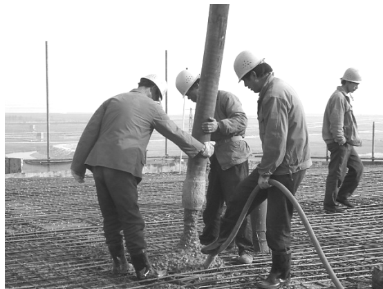
图 4：现场浇筑混凝土
