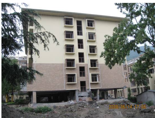
(a) 建筑全景 (a) Overview
