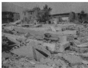
南坝镇小学教学楼全部倒塌
